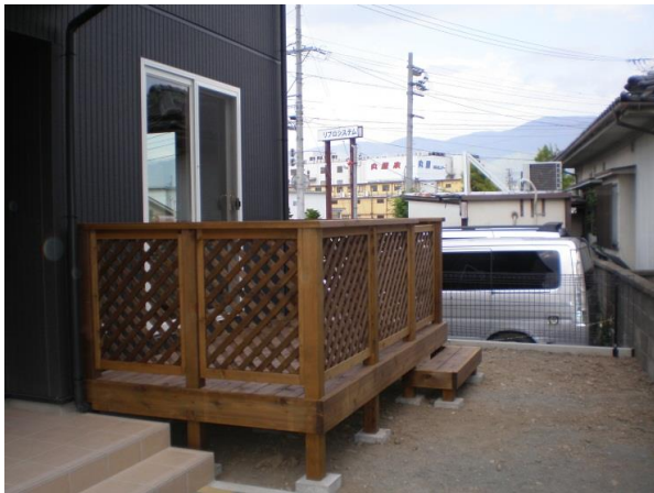
ウエスタンレッドシダーデッキB (左：クリア2回目塗装・右：施工前塗装)
