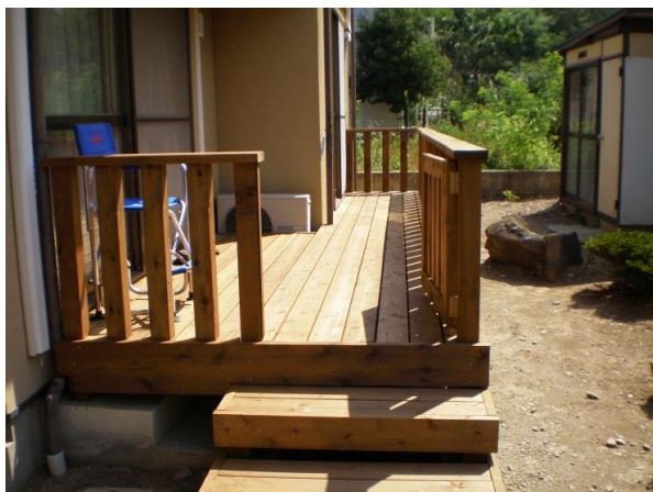
ウエスタンレッドシダーデッキB (左：クリア2回目塗装・右：施工前塗装)
