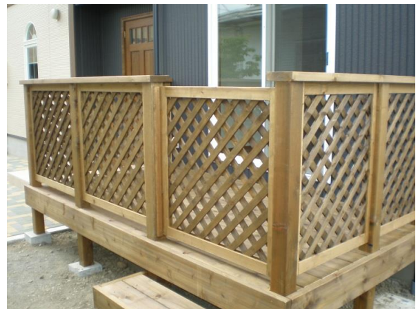
ウエスタンレッドシダーデッキB (左：クリア2回目塗装・右：施工前塗装)
